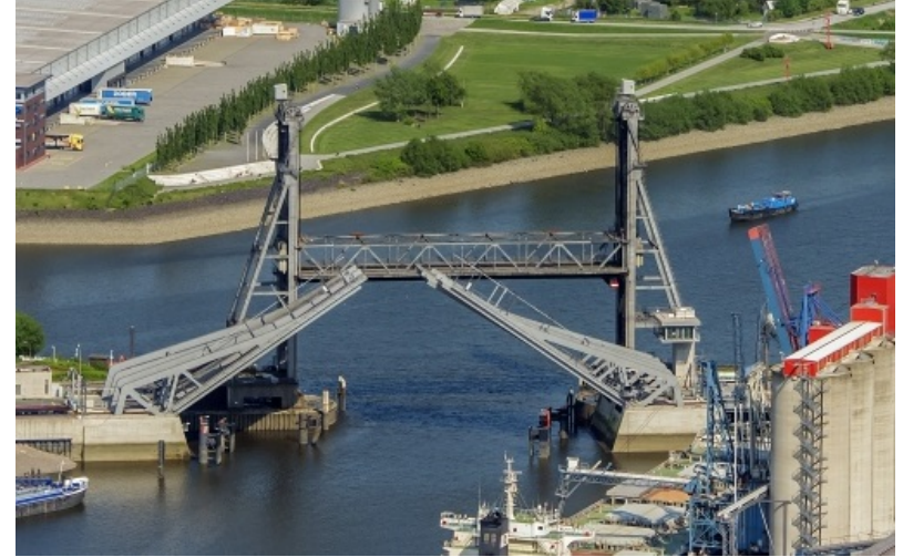
Neue und alte Rethebrücke
